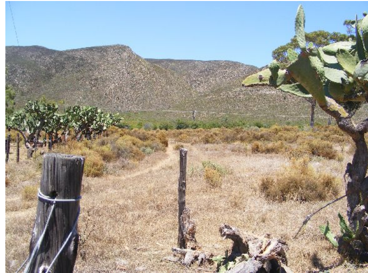
Stromleitung in Sandfontein
